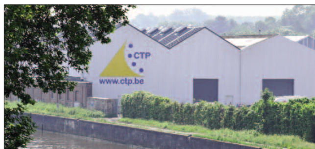
Les installations du Centre Terre et Pierre à Tournai, en bordure de l'Escaut.
